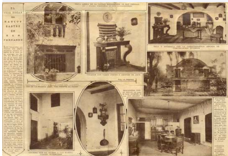
Sucasa en San Fernando Pcia. de Bs. As. Ubicada en las calles (hoy) Libertador entre Sarmiento y Madero hasta el río Luján. Fue demolida.
